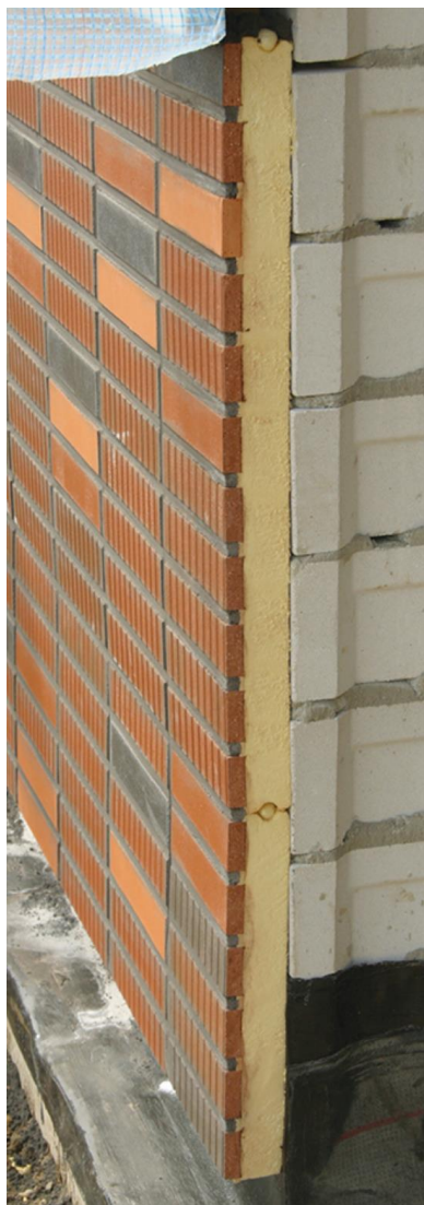
Mock-up van het gevelblad op het moment van de renovatie
