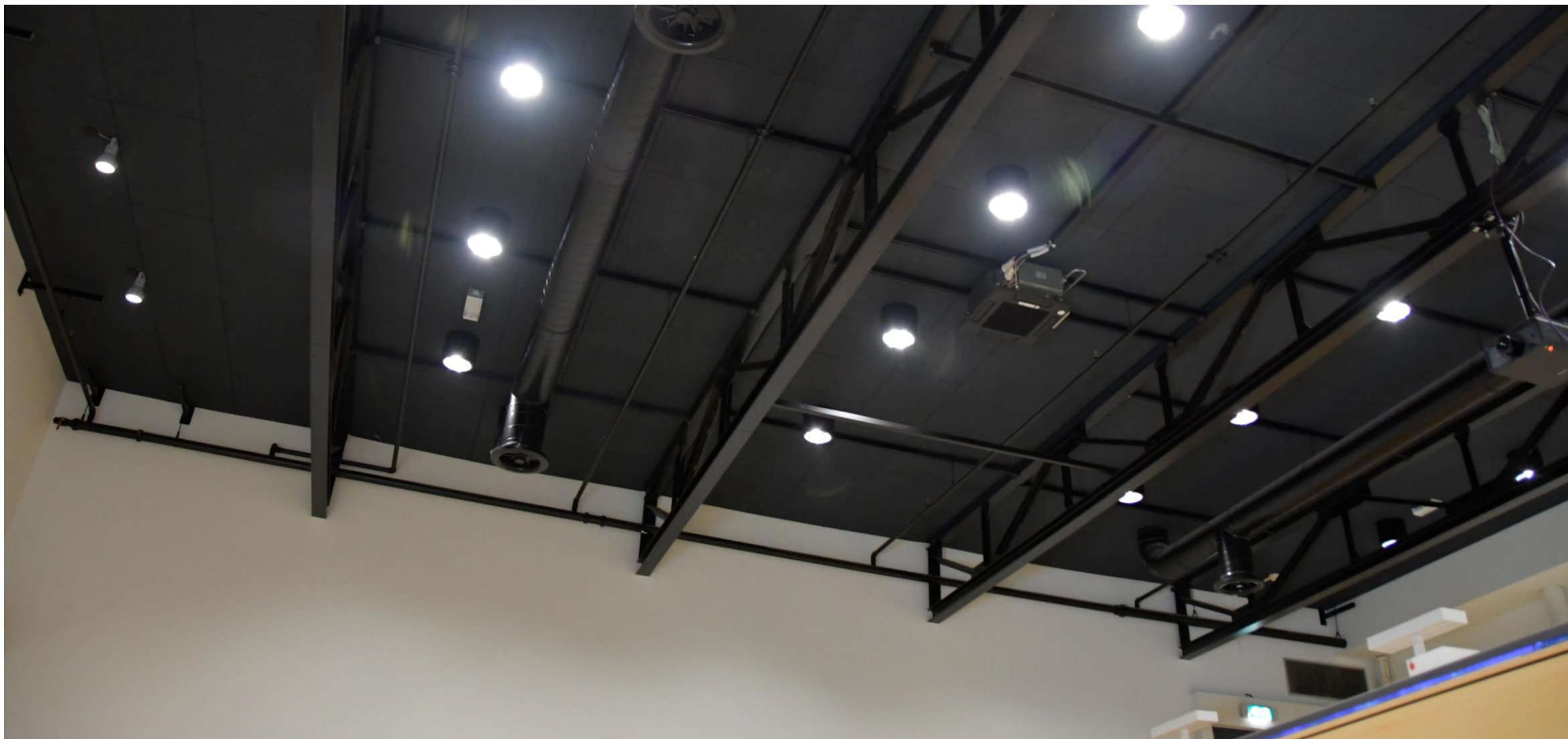
Foto van de toegepaste houtwolcementplaten als ook de zichtbaar verwerkte vakwerkliggers
