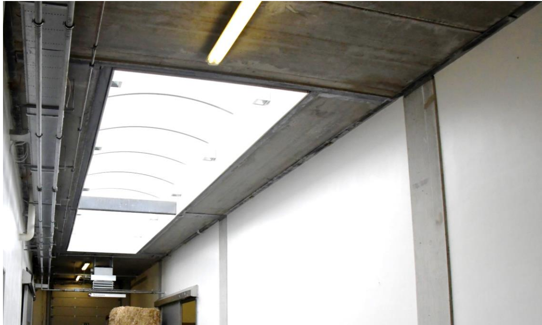
Deeluitsnede van de tekening met daarop de hoedligger en de kanaalplaatvloeren, foto's binnenzijde van de constructie C2
