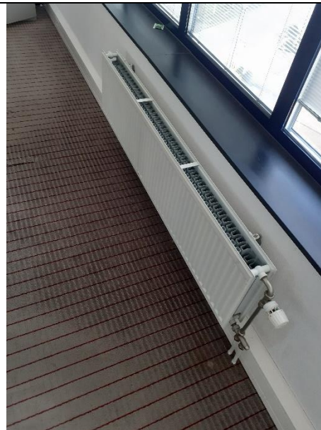
Afbeelding 73: Standaard paneelradiator met toebehoren, 1 eenheid.
