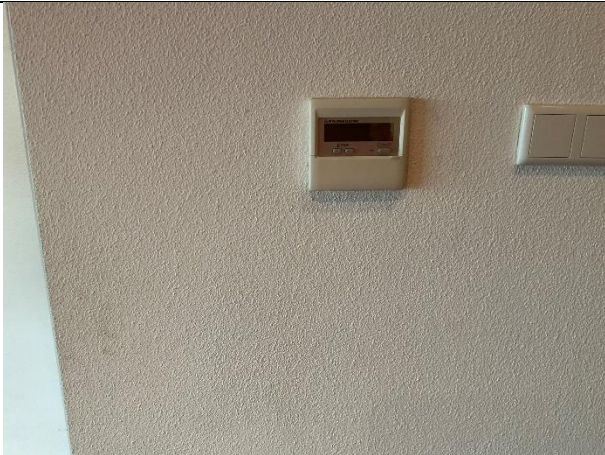
Afbeelding 49: VRF bediening/thermosstaat.
