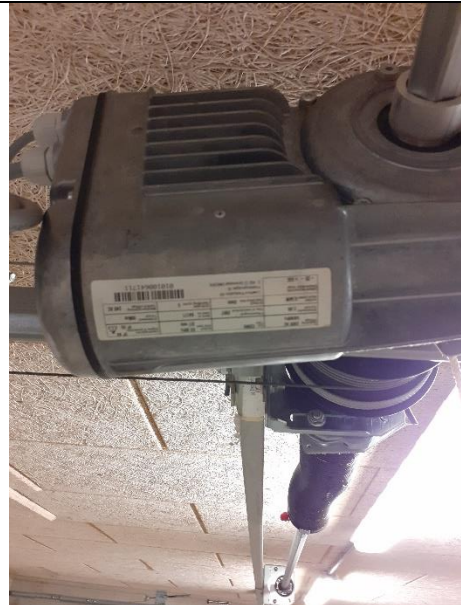
Afbeelding 46: Motor garagedeur kelder, detail.
