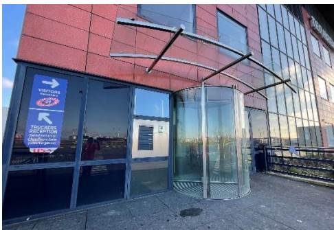
Afbeelding 29: Gevelkozijn entree uitgevoerd in aluminium, verweerde profielen maar nog in goede conditie. Entree uitgevoerd met een glazen tourniquet met luifel.
