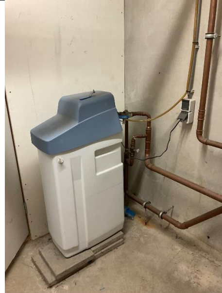
Afbeelding 38: Koudwater ontharder, 2006.
