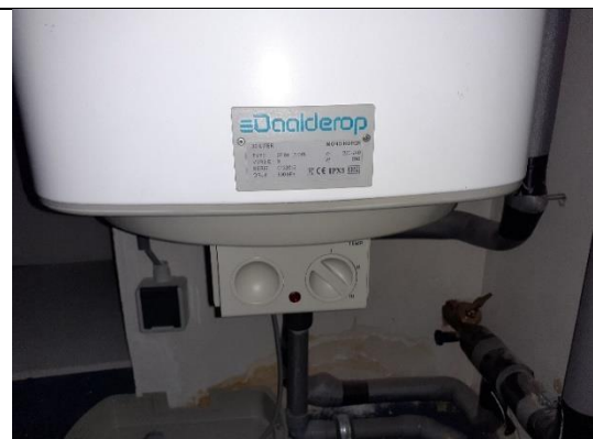
Afbeelding 103: Electroboiler Daalderop, detail.
