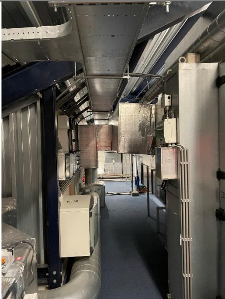
Afbeelding 89: WOLF luchtbehandelingsunit met warmtewiel, overzicht.
