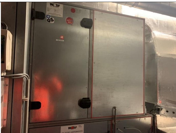
Afbeelding 87: WOLF luchtbehandelingsunit met warmtewiel.
