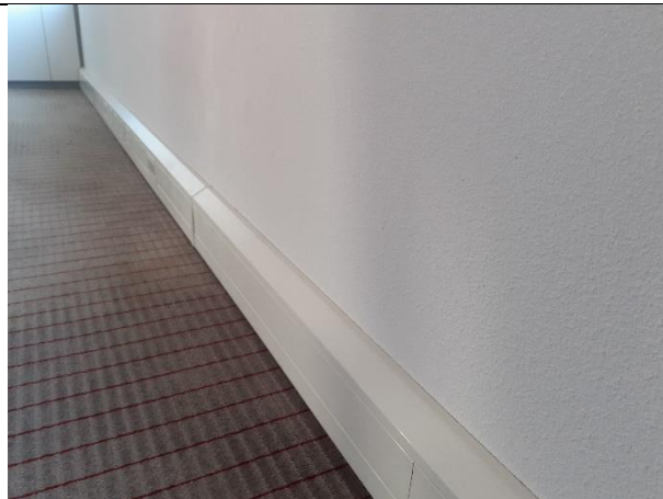
Afbeelding 69: Wandgoot, overzicht, aanwezig op verdieping 1, 2 en 3.
