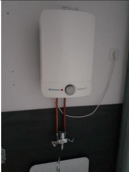
Afbeelding 52: Detail boiler, onbekend aantal eenheden door gehele gebouw.
