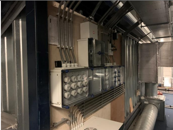
Afbeelding 85: Verdeelinrichting technische ruimte.
