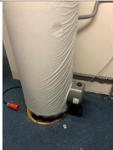
Afbeelding 84: Electrische warmwaterboiler, detail.
