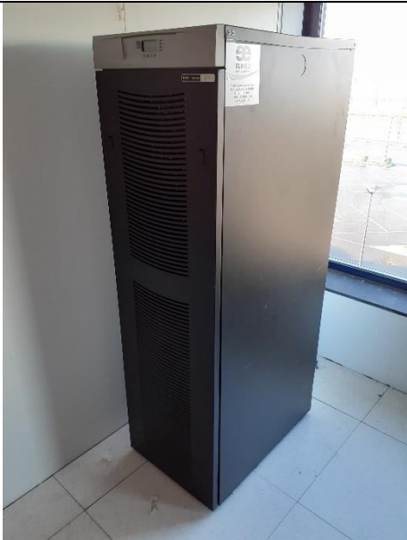
Afbeelding 60: EATON Powerware 9355, UPS, overzicht (zie ook Afbeelding 58).
