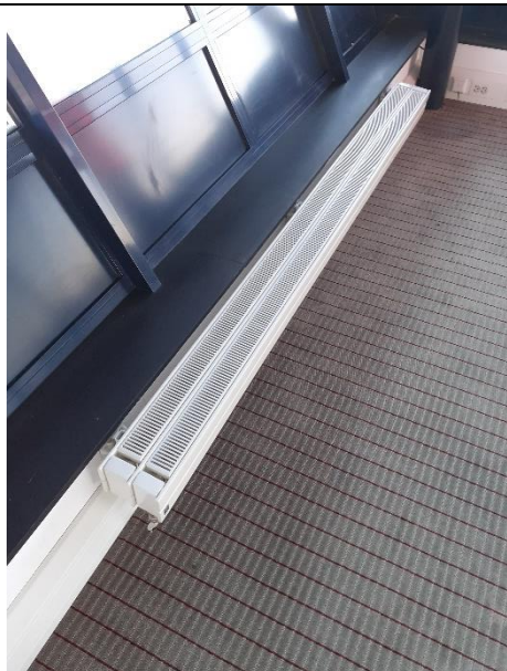
Afbeelding 72: Plinradiator met toebehoren, 4 eenheden
