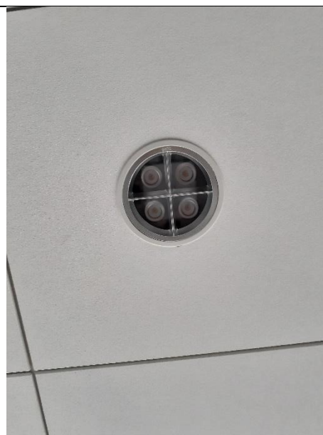
Afbeelding 75: Inbouw Led armatuur, onbekend aantal eenheden op derde verdieping (zie tekening).
