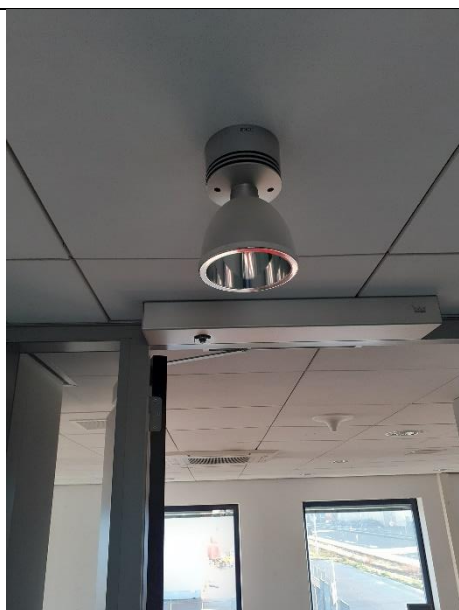
Afbeelding 74: Armatuur geschikt voor Led lichtbron, onbekend aantal eenheden verspreid over verdiepingen (zie tekeningen).
