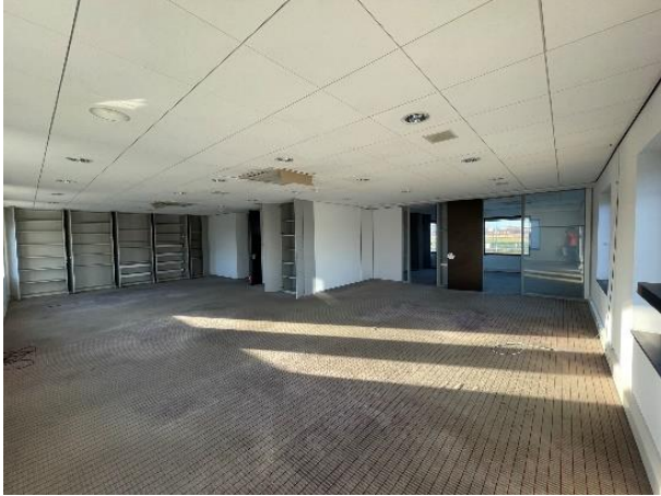
Afbeelding 15: Vloerafwerking grotendeels bestaande uit tapijt en einde levensduur.
