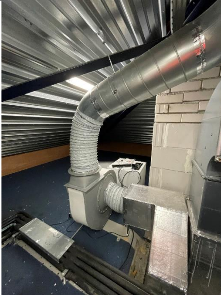
Afbeelding 81: Centrifugaal ventilator t.b.v. afzuigkap keuken.
