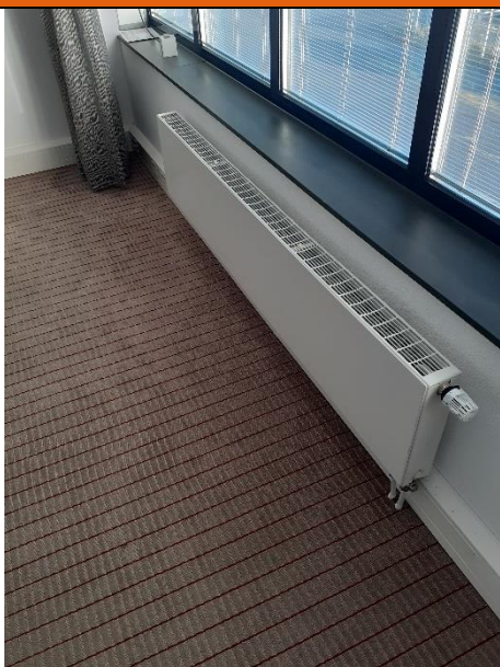
Afbeelding 70: Vlakke paneelradiator met toebehoren, 3 eenheden.
