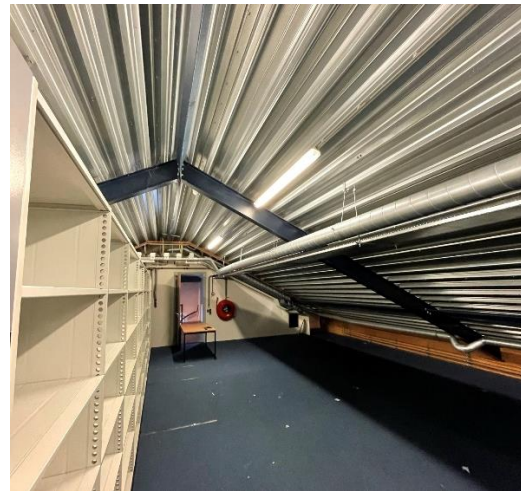
Afbeelding 10: Dakconstructie (4 e verdieping) bestaande uit staalconstructie met boutverbinding.
