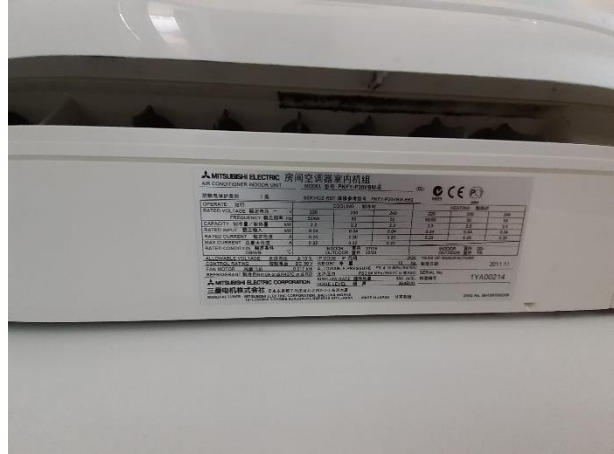
Afbeelding 53: VRF binnendeel (Airco) 2011, enkele uitzondering van de systemen komt uit 2011. Het grootste gedeelte is uit 2007.
