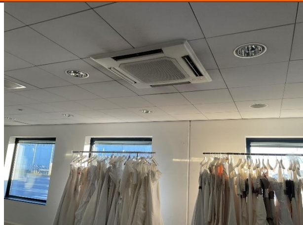
Afbeelding 48: VRF-cassette binnendeel (Airco) onbekend aantal eenheden door gehele gebouw.
