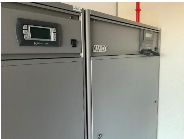
Afbeelding 62: Twee AMICO/Uniflair Close Control unit (serverruimte koeling).
