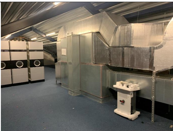
Afbeelding 91: WOLF luchtbehandelingsunit met warmtewiel, overzicht.
