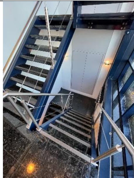
Afbeelding 12: Trappenhuis t.h.v. as 2/3 bestaande uit staalconstructie met gelijmde stenen treden.
