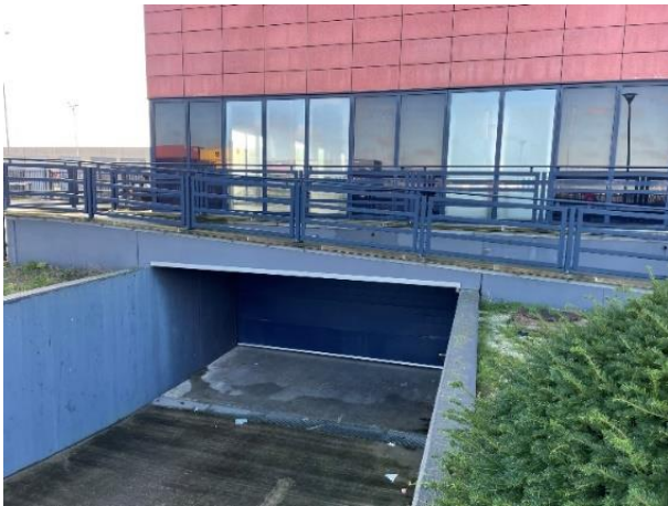
Afbeelding 13: ter plaatse van entree en inrit kelder betonconstructie bestaande uit in het werk gestorte betonvloeren en wanden.
