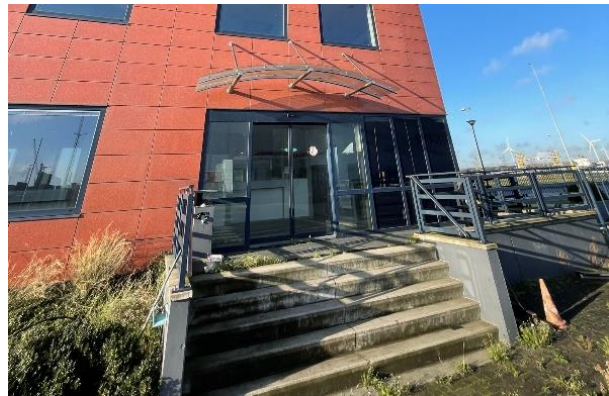
Afbeelding 14: Trapogang entree uitgevoerd in breedplaatvloer opgelegd op ringbalk. Treden uitgevoerd in prefab elementen.
