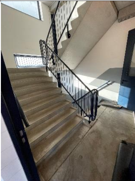
Afbeelding 11: Trappenhuis t.h.v. as 7/8 bestaande uit prefab betonnen elementen.
