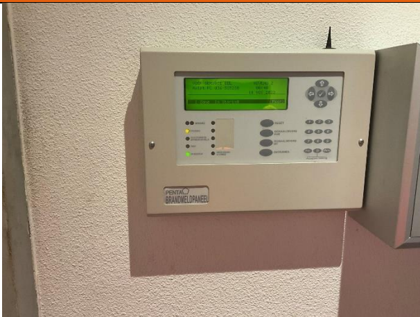
Afbeelding 47: Brandmeldcentrale.
