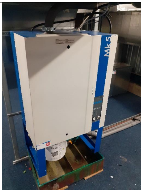
Afbeelding 94: Elektrische stoom bevochtigingsunit met kanaal bevochtiger.
