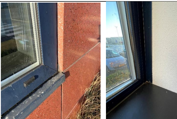
Afbeelding 23: Aluminium raamkozijnen van bgg t/m 3 e verdieping. Ca. 14 jaar oud.
