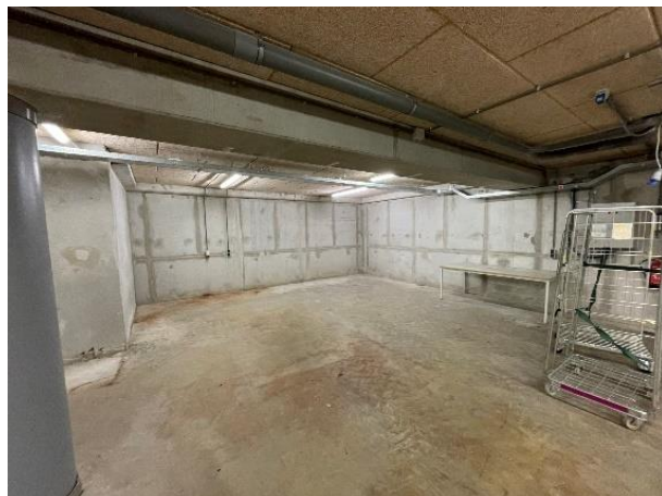
Afbeelding 4: Fragment kelder met prefab balk.
