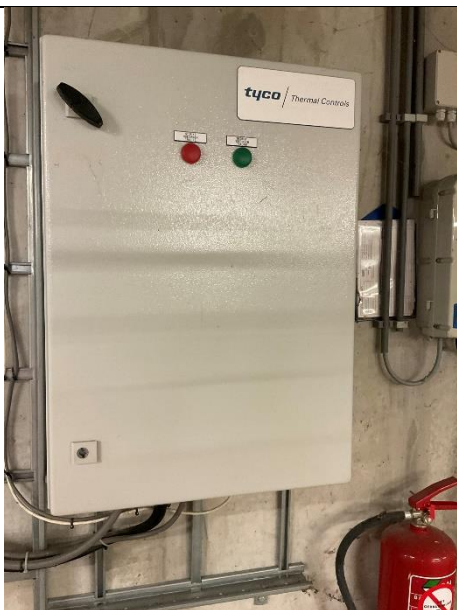
Afbeelding 43: Leiding tracing kast.
