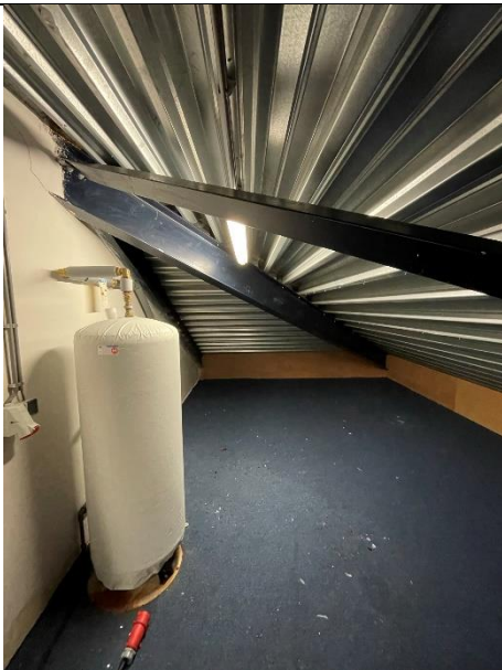
Afbeelding 83: Electrische warmwaterboiler.
