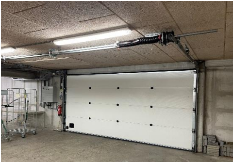
Afbeelding 31: Automatische overheaddeur voor toegang kelder. Ca. 14 jaar oud, 1 beschadigd paneel maar verder in goede conditie.
