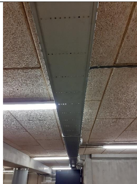
Afbeelding 40: Kabelgoot.
