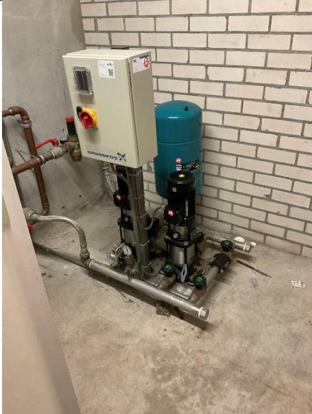
Afbeelding 37: Drinkwater hydrofoor, bouwjaar 2006.
