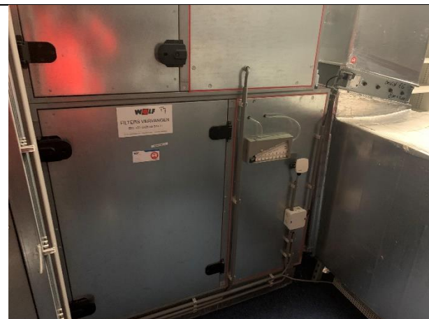
Afbeelding 88: WOLF luchtbehandelingsunit met warmtewiel.
