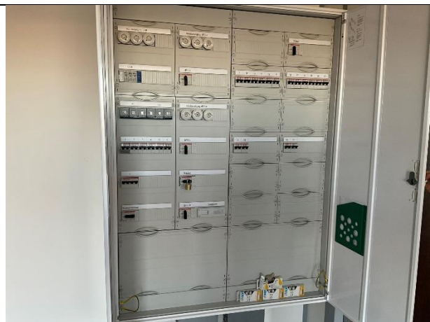
Afbeelding 63: Verdeelinrichting t.b.v. serverruimte (noodstroom).
