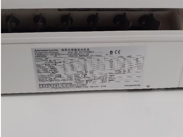
Afbeelding 76: Afbeelding 77: VRF-systeem binnendeel (Airco) 2007, meerderheid van de systemen komt uit 2007.
