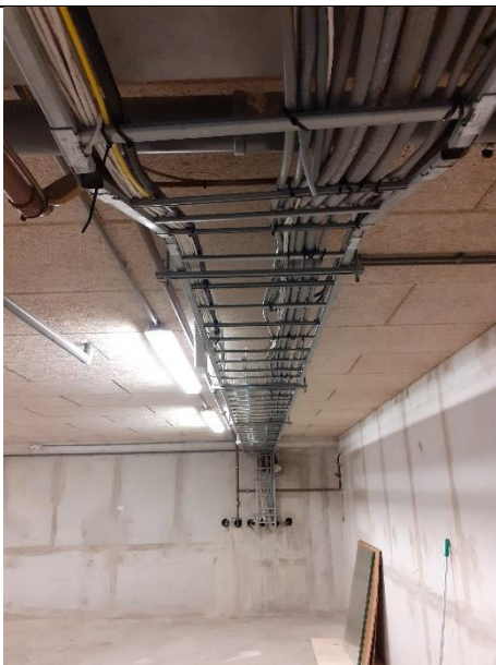
Afbeelding 39: Kabel ladder.
