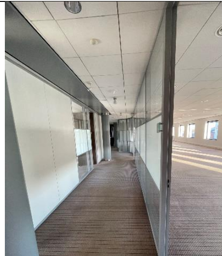
Afbeelding 18: Scheidingswanden uitgevoerd in glazen- en dichte systeemwanden met HPL-deuren, uitgevoerd met aluminium profielen en demontabel.
