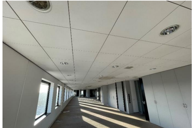
Afbeelding 16: plafondaafwerking uitgevoerd met systeemplafond, verdekt systeem. Demontabel maar einde levensduur.
