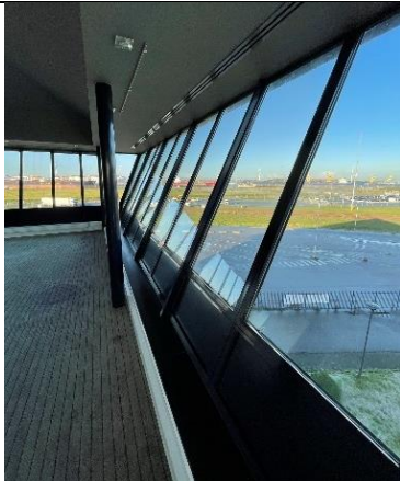
Afbeelding 27: Raamkozijnen 3 e verdieping uitgevoerd in aluminium en nog in goede conditie.
