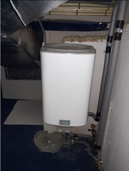
Afbeelding 104: Electroboiler Daalderop, overzicht.
