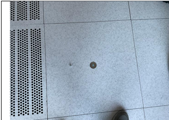
Afbeelding 64: Computervloer met vloerrooster en vluchtwegverlichting.
