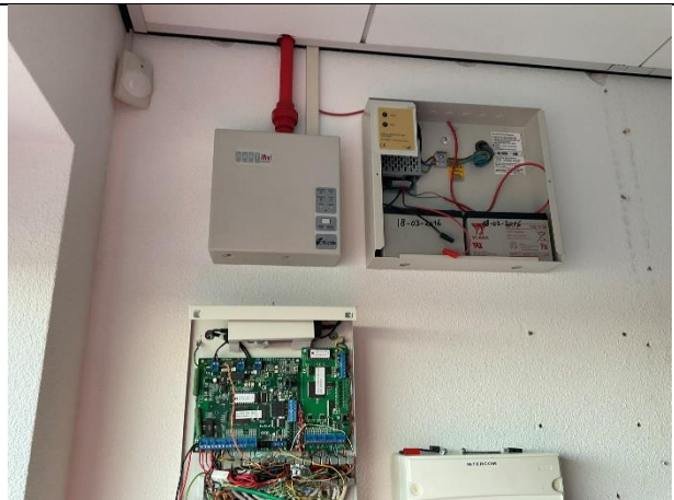
Afbeelding 65: Aspiratie brandmelder serverruimte.
