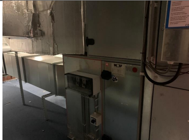
Afbeelding 86: WOLF luchtbehandelingsunit met warmtewiel.
